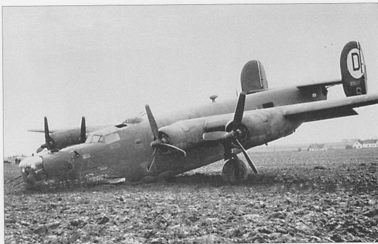
1/Lt Leander Page flög denna B-24H vid anfall mot Kiel den 4 januari 1944. Flygplanet skadades i samband med fientlig luftvärnsbeskjutning och nödlandade vid Smedstorp. När nosstället fällades in skadades planet så svårt att det måste skrotas.
