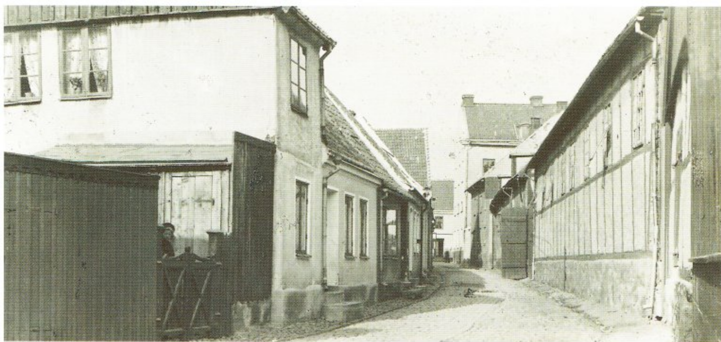
Stallgatan sedd från söder. Till höger ridhuset där senare bland annat Karlssons möbelaffär fanns.
