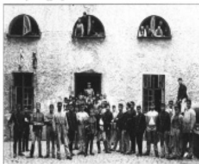
Gårdens inre från dagens kasern, gamla kasern vid Stora Östergatan i kvarteret Carl. Förelaget 1902.
